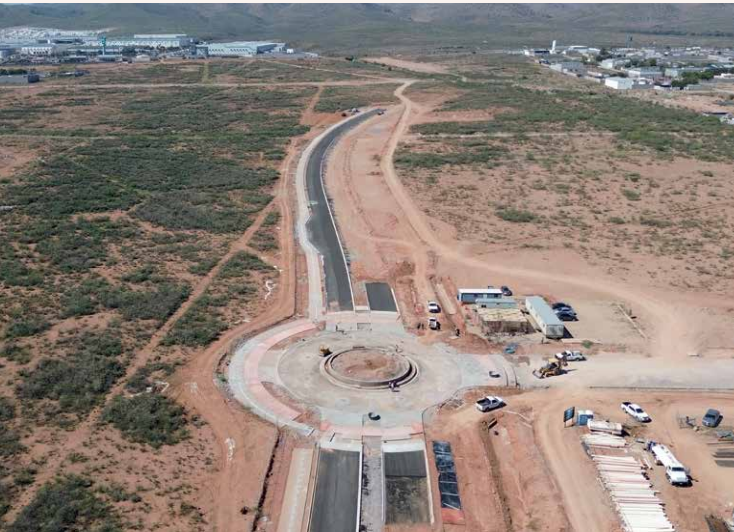
Avances de obra de rotonda - calle completa.
