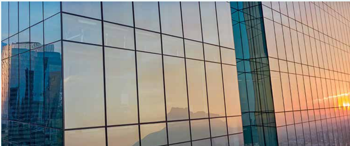
Torre Manacar - Vidrio Solarban® R100 y Vidrio Starphire®
